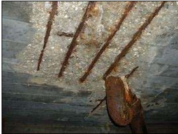
FIG. 28 : CORROSION EFFECT
