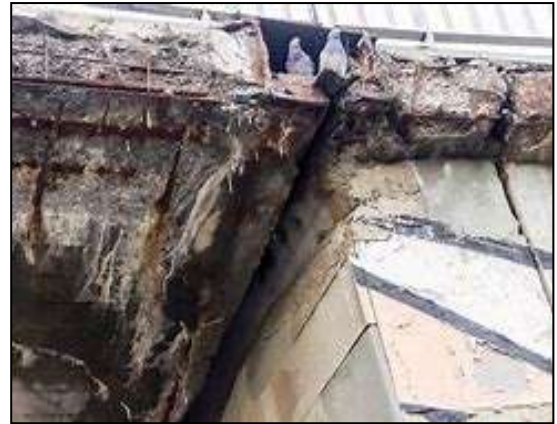
FIG. 28 : CORROSION EFFECT
